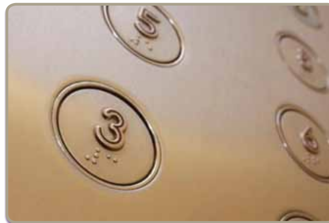
Abbildung 11 – Aufzug-Bedienungstafel mit taktiler und Brailleschrift
