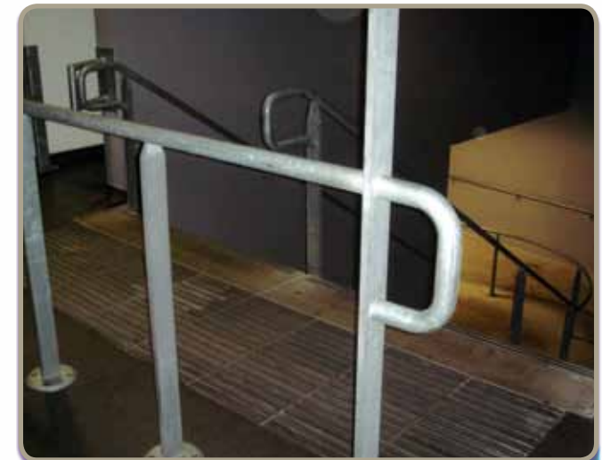
Abbildung 16 – Taktile Oberfläche (als Warnhinweis) mit Barriere am oberen Treppenende
