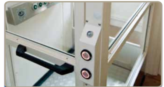
Abbildung 13 – Geschlossener Plattformlift
