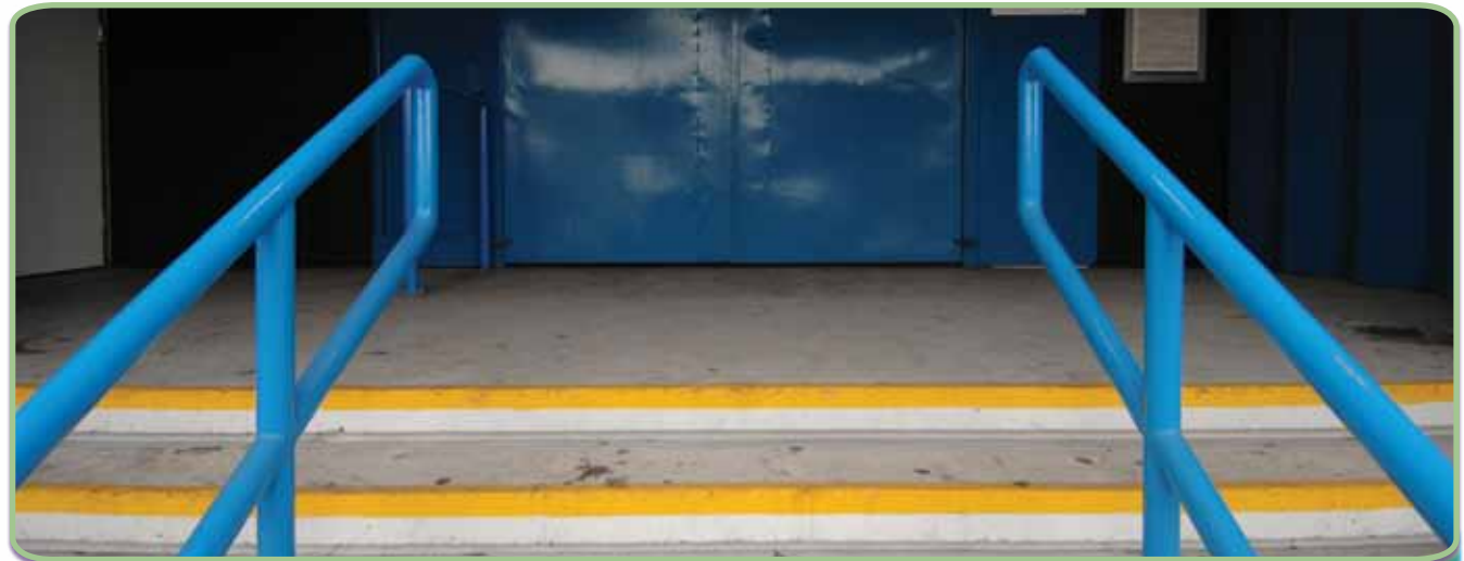
Abbildung 9 – Farbkontraste auf Treppenstufen
