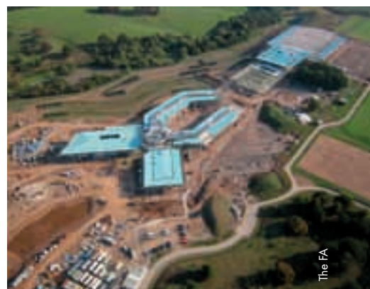
Das neue Zentrum nimmt Form an.
