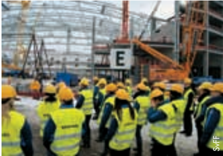
Das schwedische Frauennationalteam besucht die Baustelle des neuen Nationalstadions.
